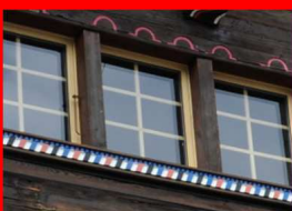
Fig. 8 Fenêtre à un vantail avec double vitrage et croisillons intérieurs
