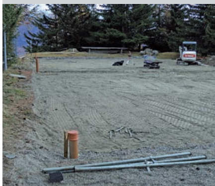
Début des travaux de la patinoire.
