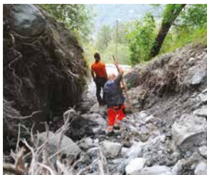
Torrent de la Corniolla: tronçon profondément érodé.
