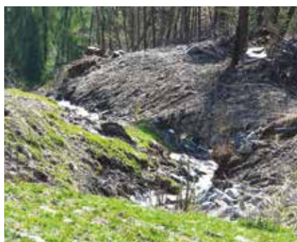
Torrent de la Corniolla entre les Verneys et RC Hérémence: déboisement, reprofilage du lit, drainages et ensemencement.
