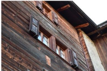
Détail des fenêtres à cadres transformées (N). © Photo Safiya Salamin & Tiago Dosantos Morais, 2025.
