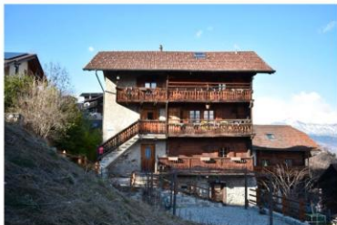
Vue de la façade latérale avec galeries (S). © Photo Safiya Salamin & Tiago Dosantos Morais, 2025.
