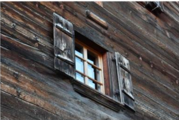
Détail d'une fenêtre originale (N). © Photo Safiya Salamin & Tiago Dosantos Morais, 2025.
