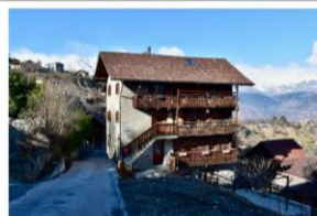
Vue des façades en arriéré (S-O). © Photo Salfia Salamin & Tiago Dosantos Morais, 2025.
