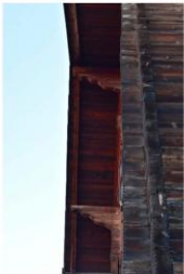
Détail des madriers à arrêtes brisées (N-O). © Photo Safiya Salamin & Tiago Dosantos Morais, 2025.
