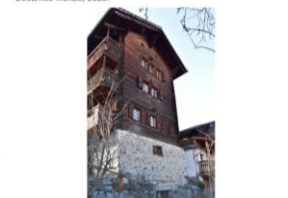
Vue de la façade principale en aval (E). © Photo Salfia Salamin & Tiago Dosantos Morais, 2025.
