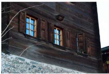
Détail des fenêtres originales (E). © Photo Safiya Salamin & Tiago Dosantos Morais, 2025.
